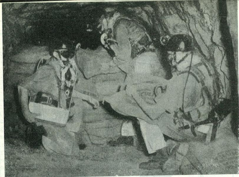
Una brigada de la Estación de Práctica de Salvamento de la Cámara de Minas, ocupada en la construcción de un muro con sacos de vermiculita, para detener el fuego a la entrada de un túnel. Uno de los hombres va provisto de un transmisor.
